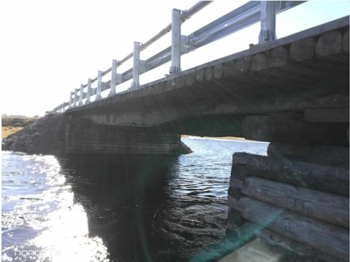
Фото 13. Пк 4+02 профиль моста на объездной дороге левая сторона.
