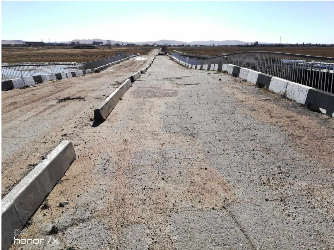
Фото 9. ПКЗ+72 вид в сторону конца участка, выгиб мостового перехода.
