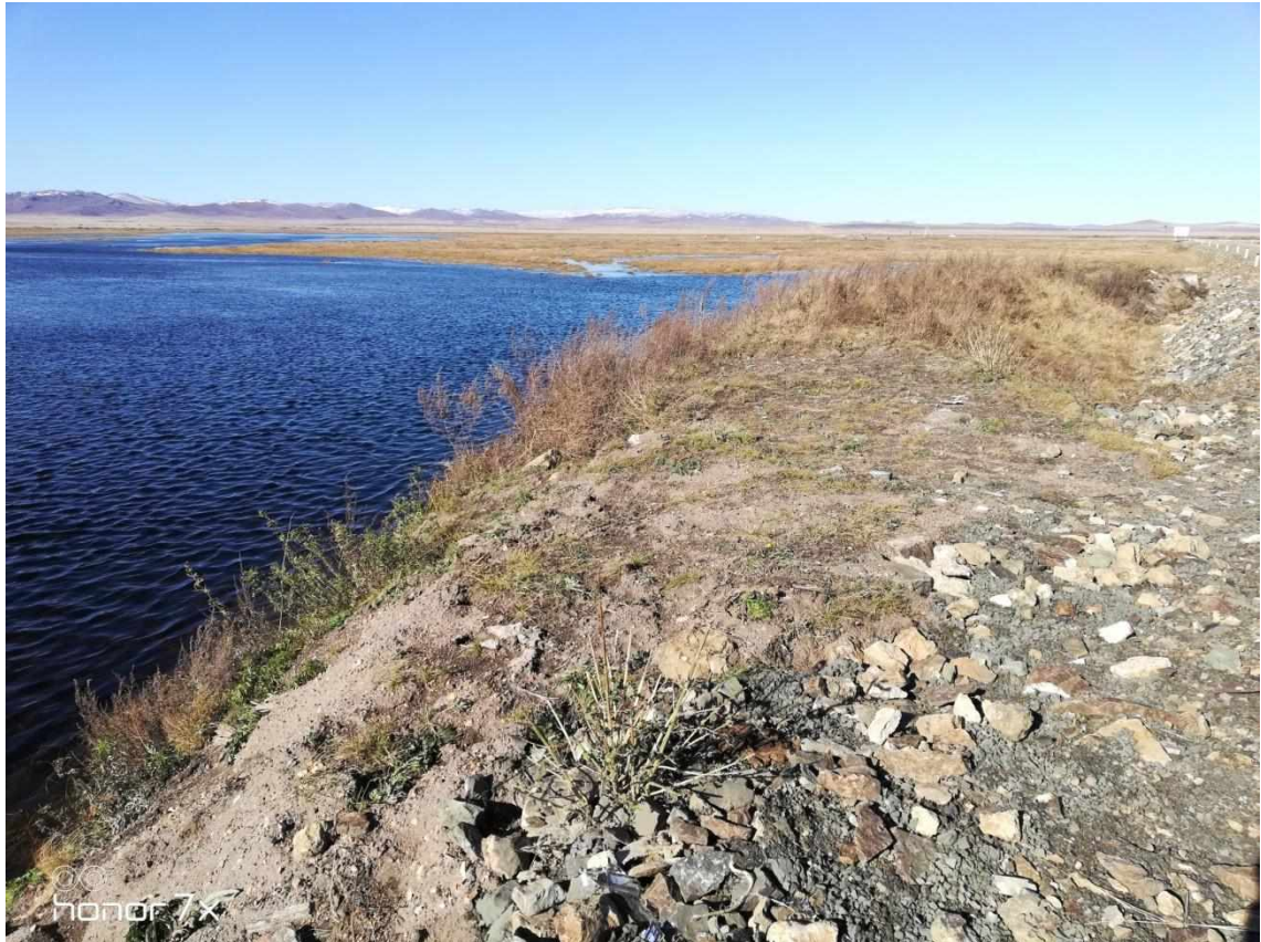
Фото 7. ПК3+45 вид с объездной дороги на дамбу в сторону начала участка.
