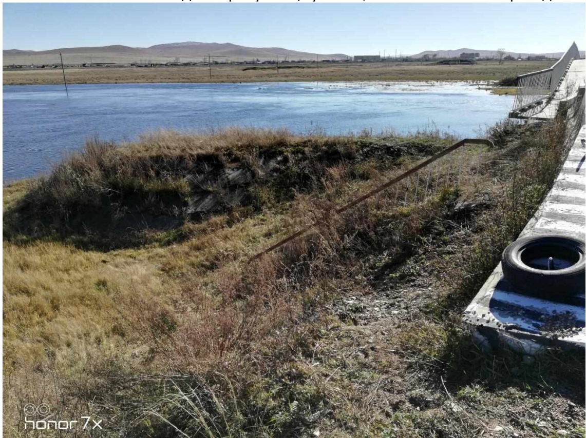
Фото 10. Начало моста вид на дамбу с левой стороны.
