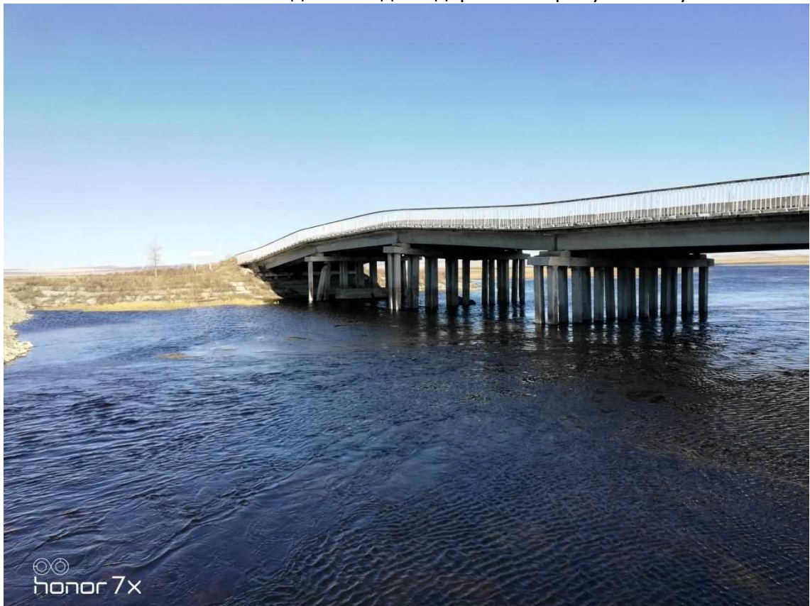
Фото 16. ПК 4+43 профиль правой стороны моста.
