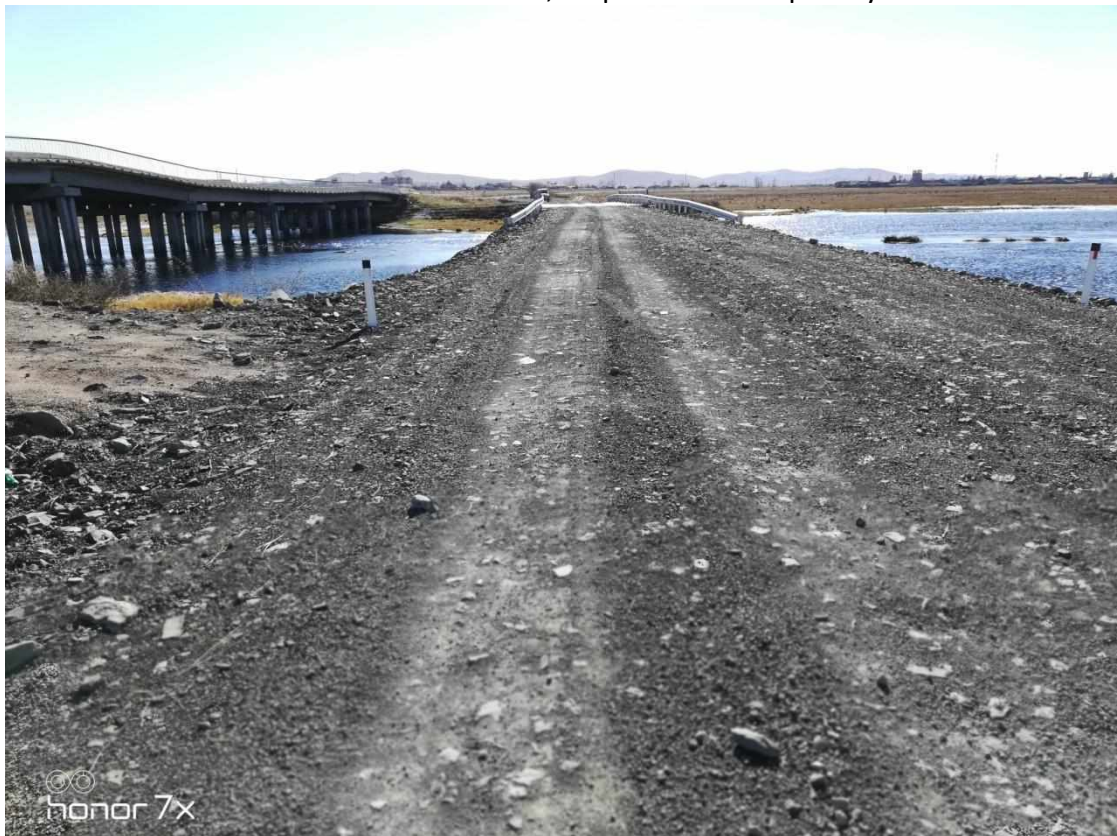
Фото 6. ПКЗ+45, объездная дорога вид в сторону конца участка.
