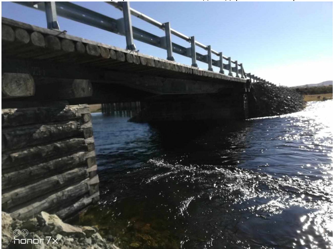
Фото 14. ПК 4+02 профиль моста на объездной дороге правая сторона.
