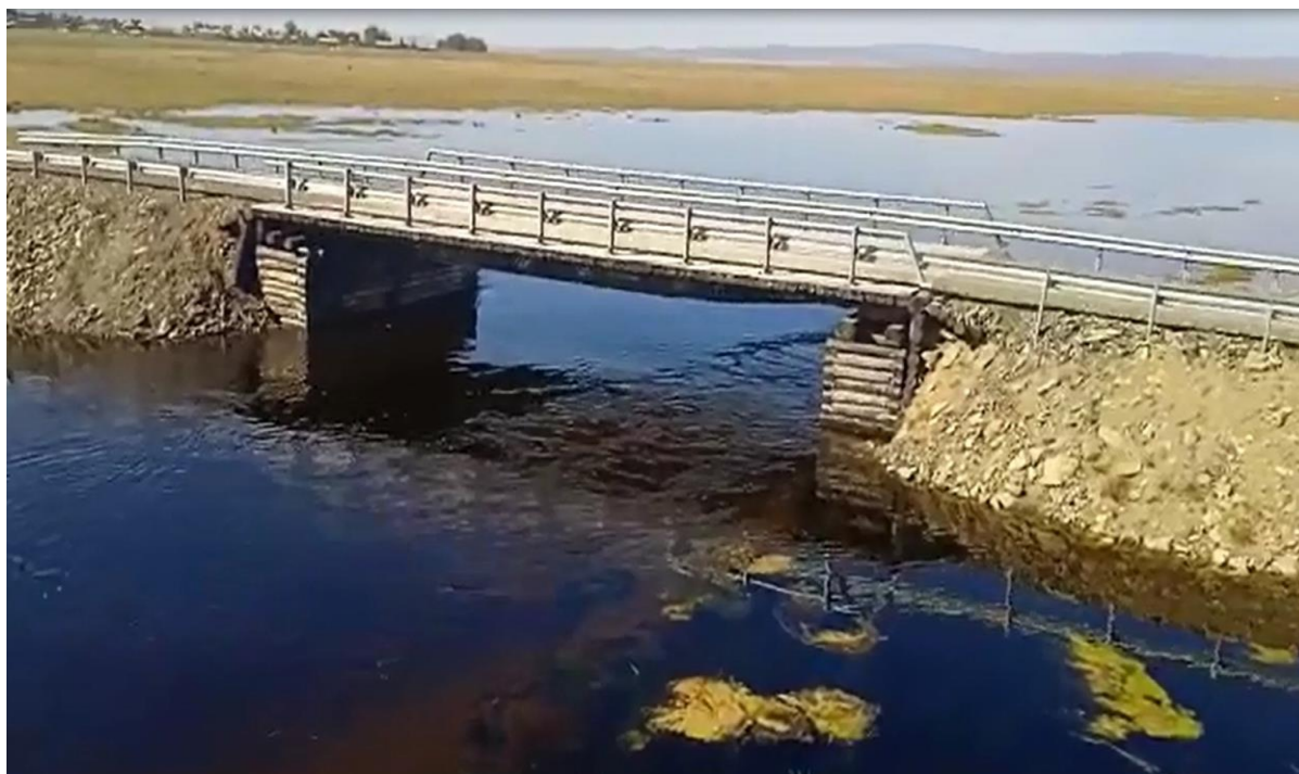
Временный деревянный мост через р. Урулюнгуй
