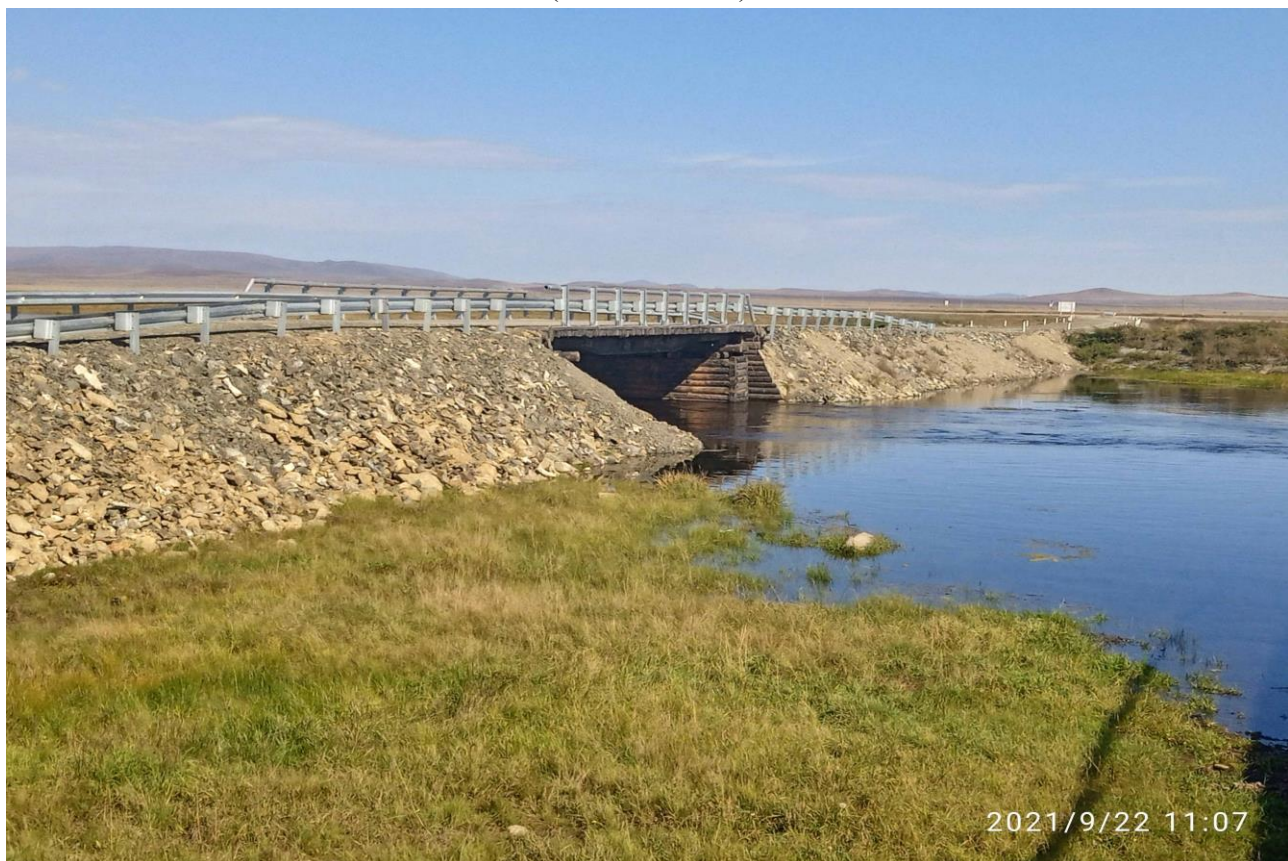
Временный проезд через р. Урулунгуй
